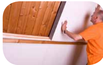
Het aanbrengen van een isolatiepakket aan de binnenzijde van de woning
