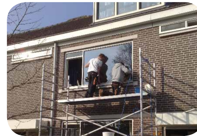
Aanbrengen van ventilatieroosters
